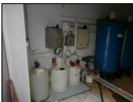
Slika 1.5. Uređaj za pročišćavanje vode iz bunara
